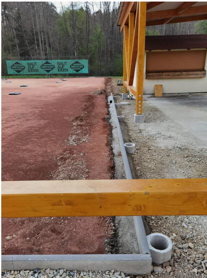
Abbildung 5: Instandsetzung des Zauns auf der Südseite.
